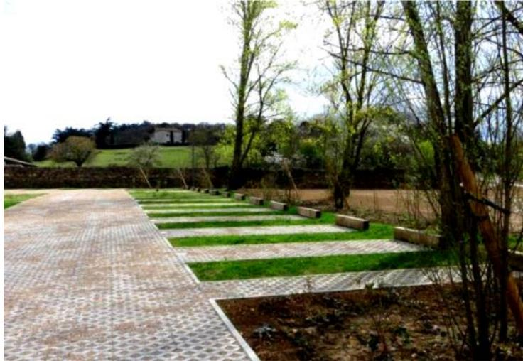
Figure 25 : Désimperméabilisation d'un parking enrobé à Laveyron (Drôme).
