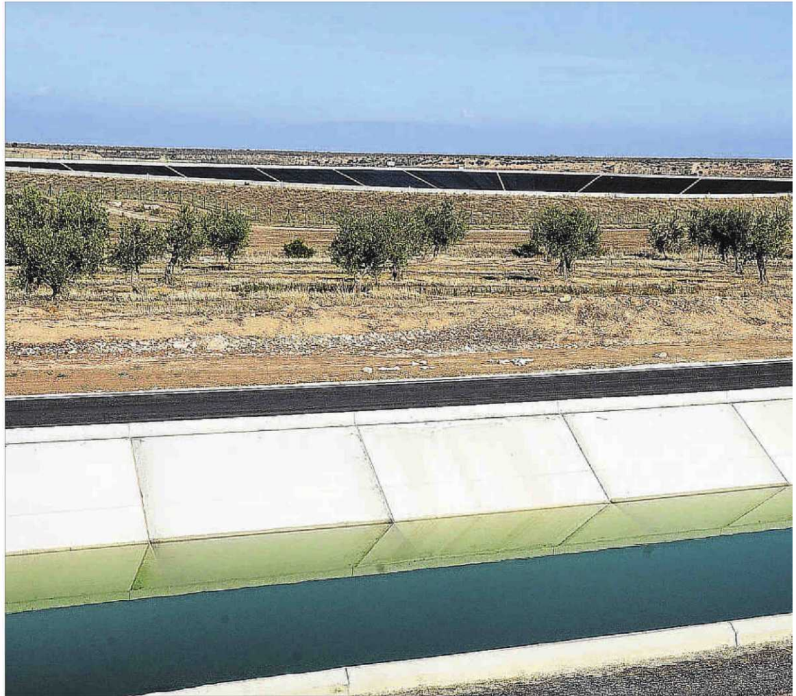
Canal Segarra-Garrigues a Maldà (Urgell) amb una bassa de regulació buida al fons
