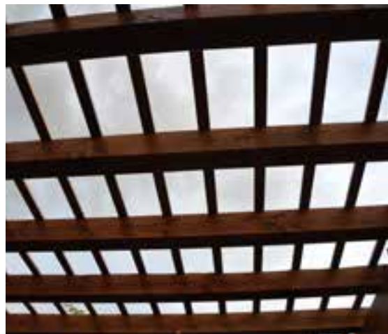
Fotografia 16 – Estructura de fusta massissa d'avet Douglas, Sant Hilari Sacalm.
