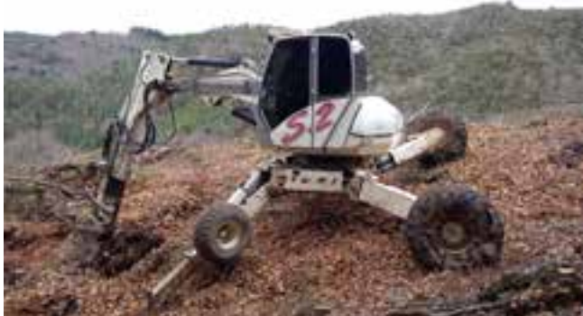
Fotografia 8 – Obertura de forats amb retroaranya, finca Reixach de Sant Hilari Sacalm.
